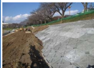
H27年度 護岸施工状況 (H27.12)
