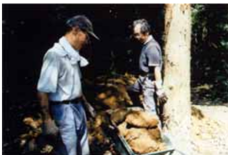
8月28日 三角堰の設置作業玉石・赤土を搬入
