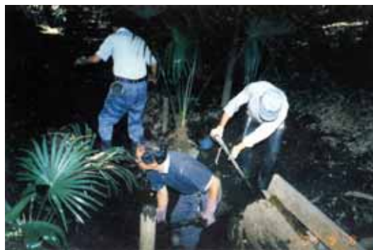
9月8日 水路の整備作業
