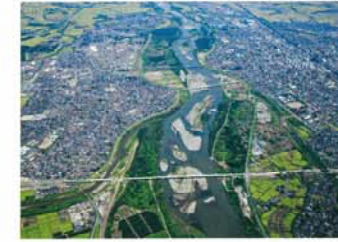
長岡市街地と信濃川(長岡市全景)
