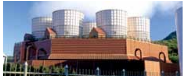
柳津西山地熱発電所
