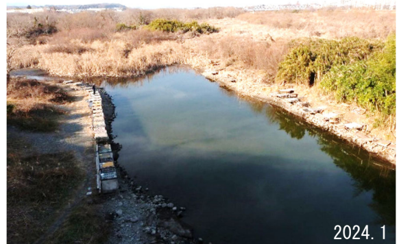
写真-1 釣りのための足場が設置されているワンド
