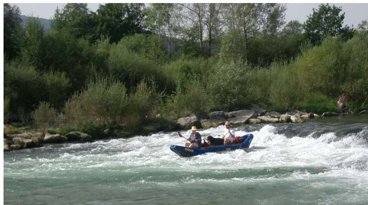
↓ロイサッハ川（ドイツ） 落差処理を石積みのランプ工で行うことにより、河床低下の抑制に加え、魚類の移動やカヌーでの利用を可能とした例
