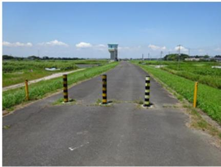
取り外しにより管理車両の通行幅を確保する。
