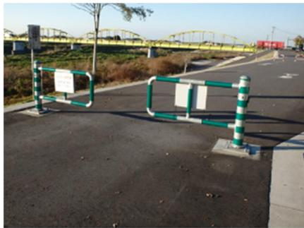
旋回やスライドにより管理用車両の通行幅を確認する。
