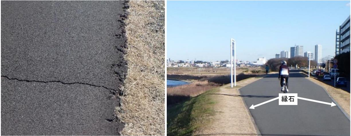
図 40 舗装端部から損傷（左）、舗装端部に縁石設置（右）
