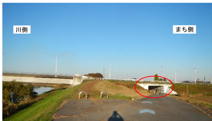
図 14 堤内地（まち側）に設置されたアンダーパスの事例
