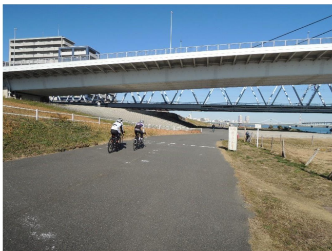
図 15 堤外地（川側）に設置されたアンダーパスの事例（緊急用河川敷道路）
